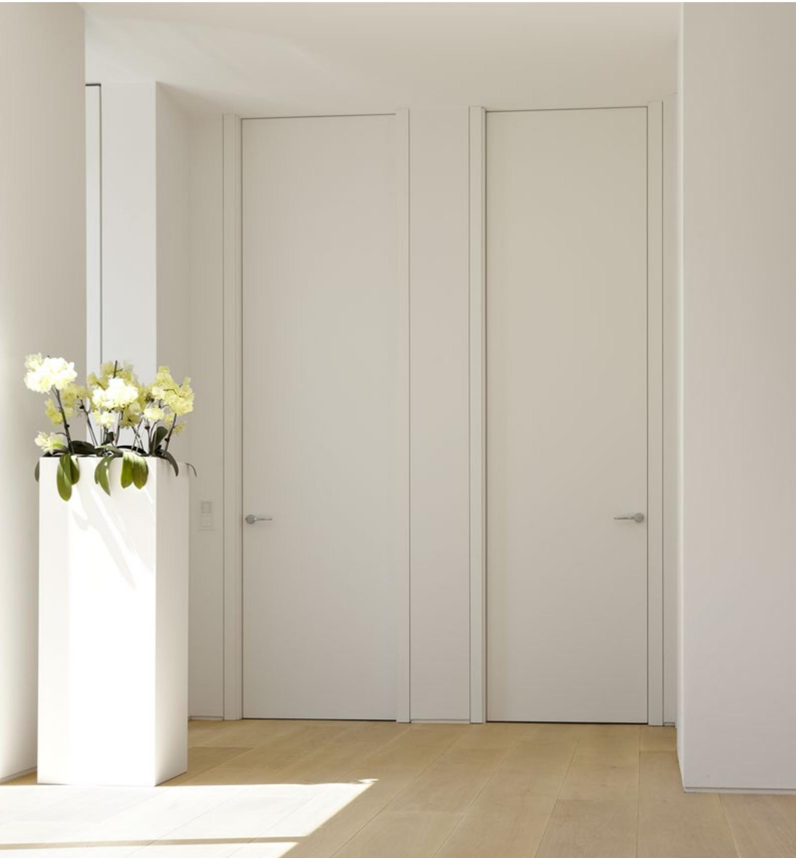
Türblatt 62 mm, Typ G | Ausführung stumpf, 3 verdeckte Bänder und Magnetschloss | Schleiflack weiß RAL 9016
