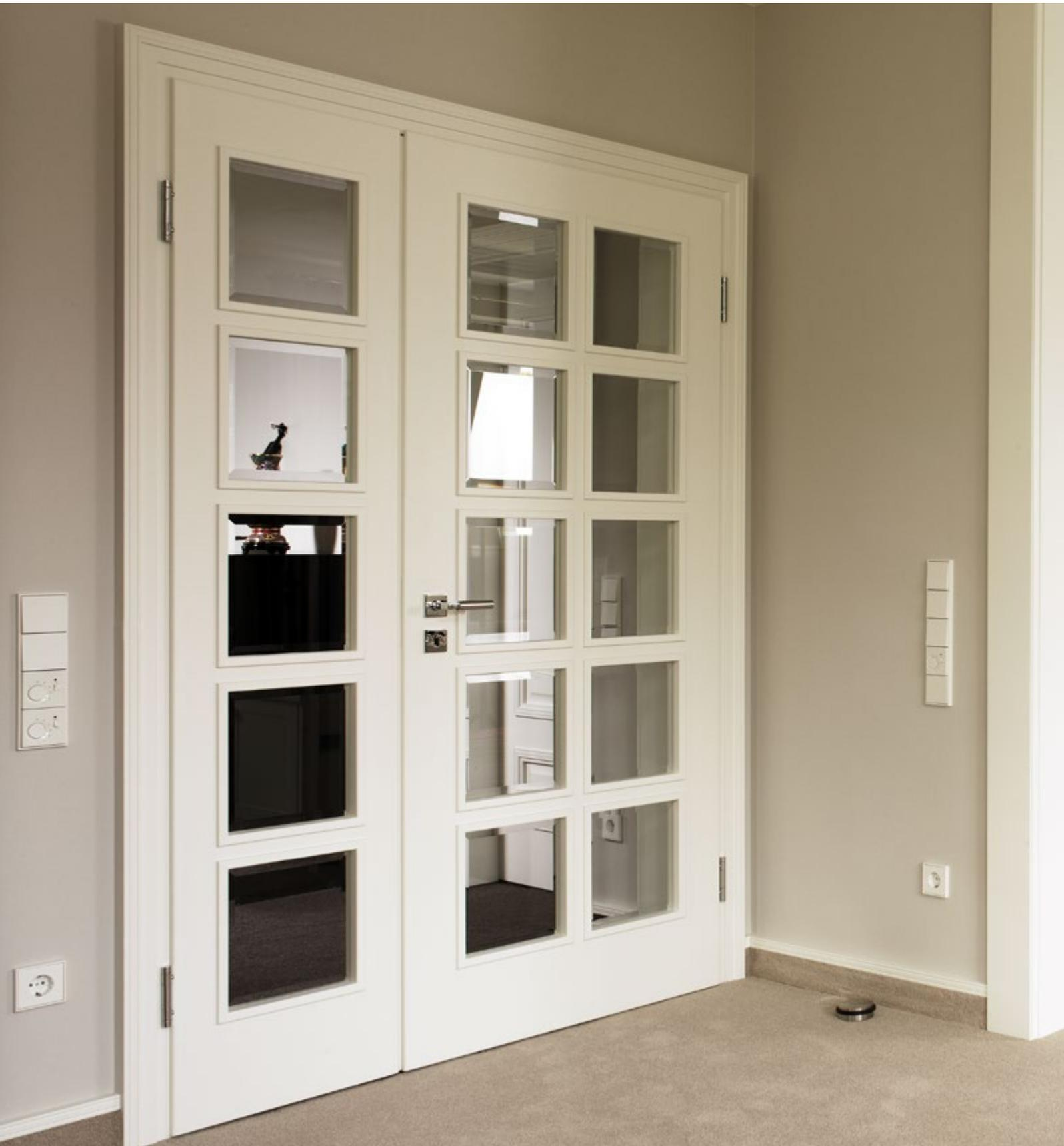
Türblatt Typ G10 mit Verglasung | Doppeltür mit unterschiedlichen Flügelbreiten | Klarglas mit Facette | Bekleidung T95 | Schleiflack weiß RAL 9016
