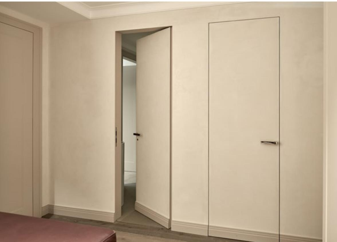
Türblatt Typ G | Ausführung als Tapetentür | mit durchlaufender Fußleiste
