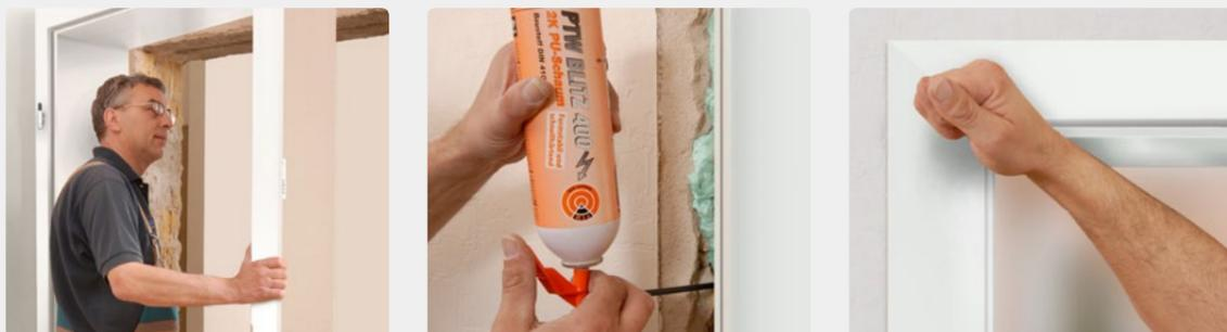
Nach dem Anpassen der Fußleiste an die neue Zargenbekleidung wird die Zarge einfach in die Maueröffnung gestellt, ausgerichtet und mit Türspreizen fixiert. Mit speziellem Montageschaum wird der fachgerechte Einbau der neuen Zarge fortgesetzt. Nach dem Aushärten des Montageschaums wird die Zierbekleidung aufgesteckt, das neue Türblatt eingehängt und der Türdrücker aufgeschraubt – fertig!
