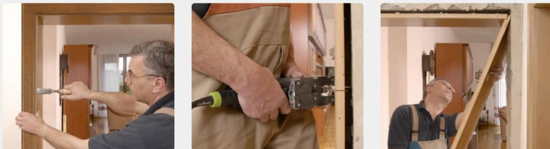
Die Tapete wird um die Bekleidung herum sauber eingeschnitten. Mit einem Stecheisen wird die Zierbekleidung von der Zarge gedrückt und das Futterbrett der Zarge im unteren Drittel mit einem sauberen Schnitt durchgesägt. Danach lässt sich die Zarge problemlos ausbauen. Bei der gesamten Demontage fällt kein nennenswerter Schmutz an, da keine Stemmarbeiten oder Ähnliches erforderlich sind.
