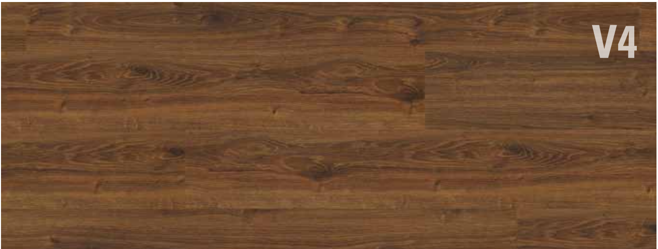
Verlegte Fläche Dakota Oak | umlaufende V4 Fuge
